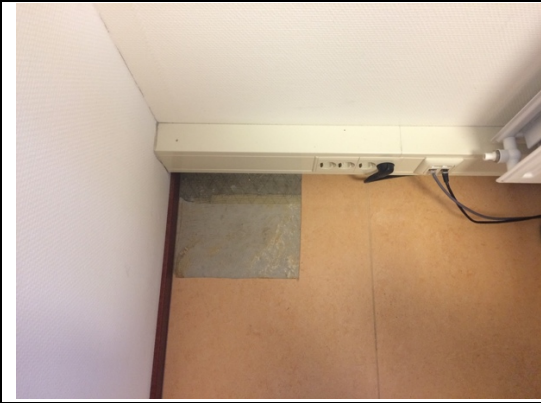
Foto 3: Vloerbedekking zit koud op beton.
